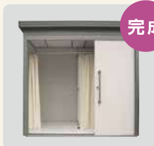
6 在另一側的隔簾軌道上安裝隔簾。
